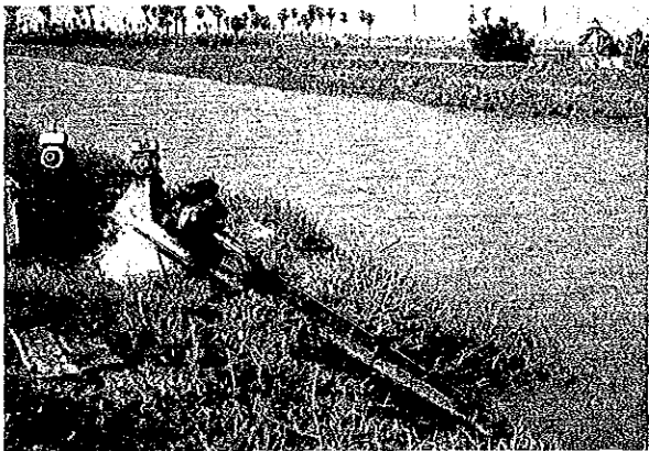
(62) 揚水ポンプ ( Rayong 中央( 3.16 ) )
