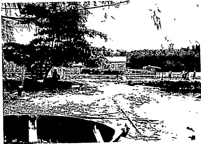
(Construction Site: Gizo)
