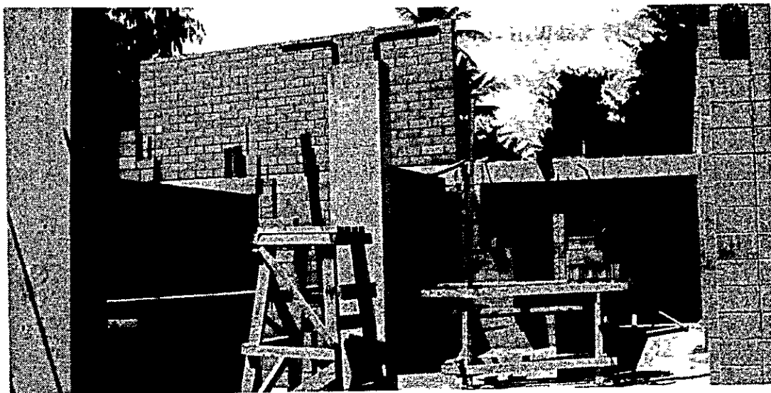
現地施工中の建物（大蔵省新庁舎）
