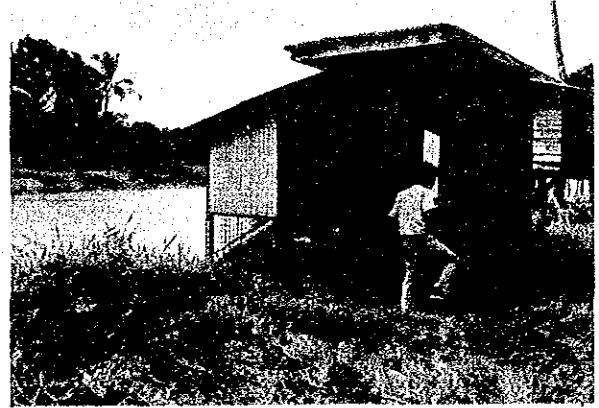
コロンビア農業試験場の揚水ポンプ小屋
