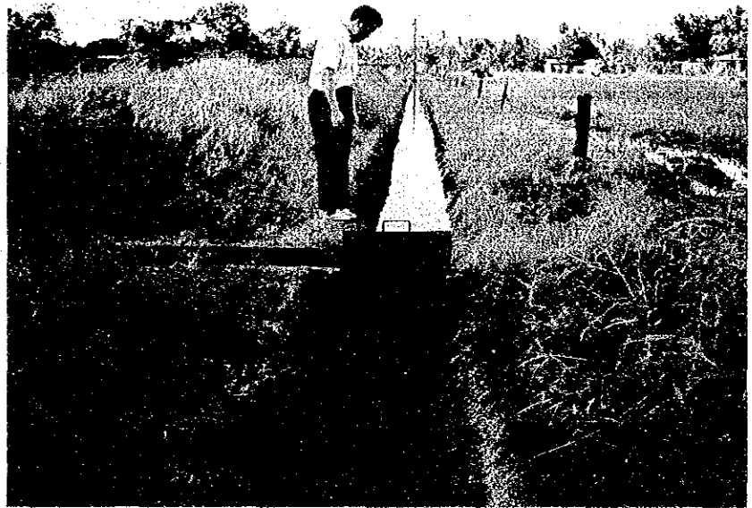
幹線用水路 (コンクリートライニング)
