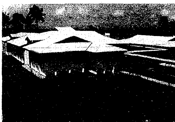
ニュージーランドの援助により建設されたコロニア試験場作物保護棟、機材は入っていない。
