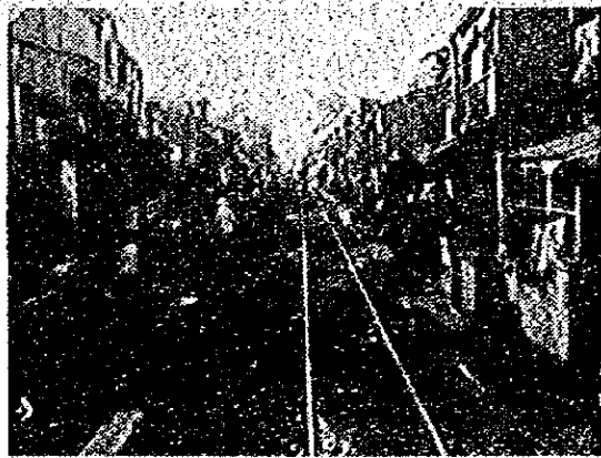
Saigon 市内における線路の状況、民家が建築限界をわかし使用停止中の軌道上に民衆があふれている。また軌道内の水溜りも目立つ。
