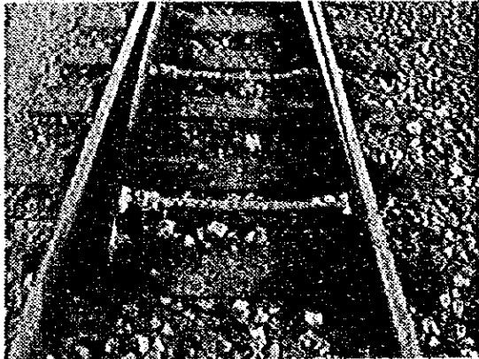
Danang~Hue 間の小駅における分岐器の転てつ部。マクラギの老朽劣化の著しさと転てつ部の貧弱さが明瞭。
