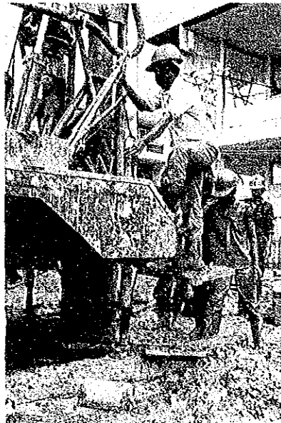
現場打コンクリートパイルオーガー掘削施工中 (HAADAY 病院)
