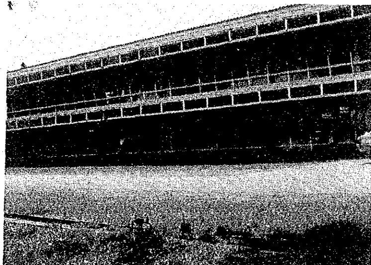
地方のPHC訓練 センターが建設され る予定のコンケン Public Health College
