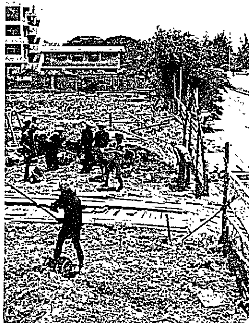
国立がんセンター建設現場
