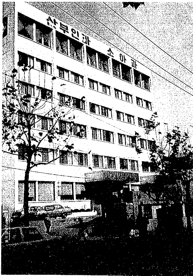
プロジェクトの拠点となっている順天郷大学 韓国母子保健センター
