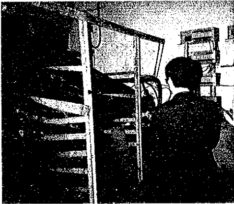
ガンビール-I局の加入者線終端巻上げの様子
