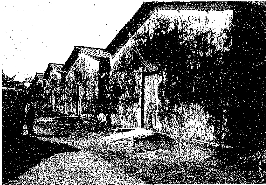
鉄線保管用倉庫の例
