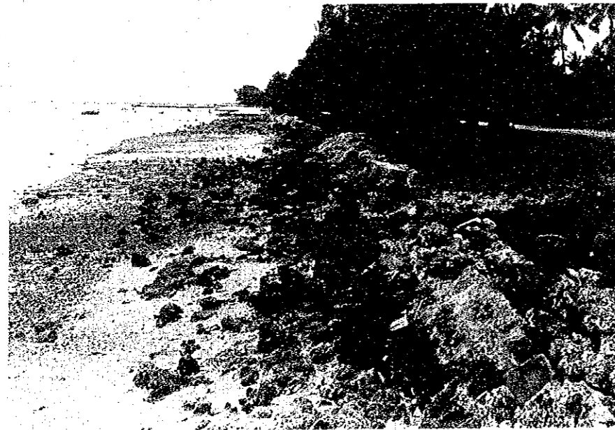
西側既設護岸（石積式）
