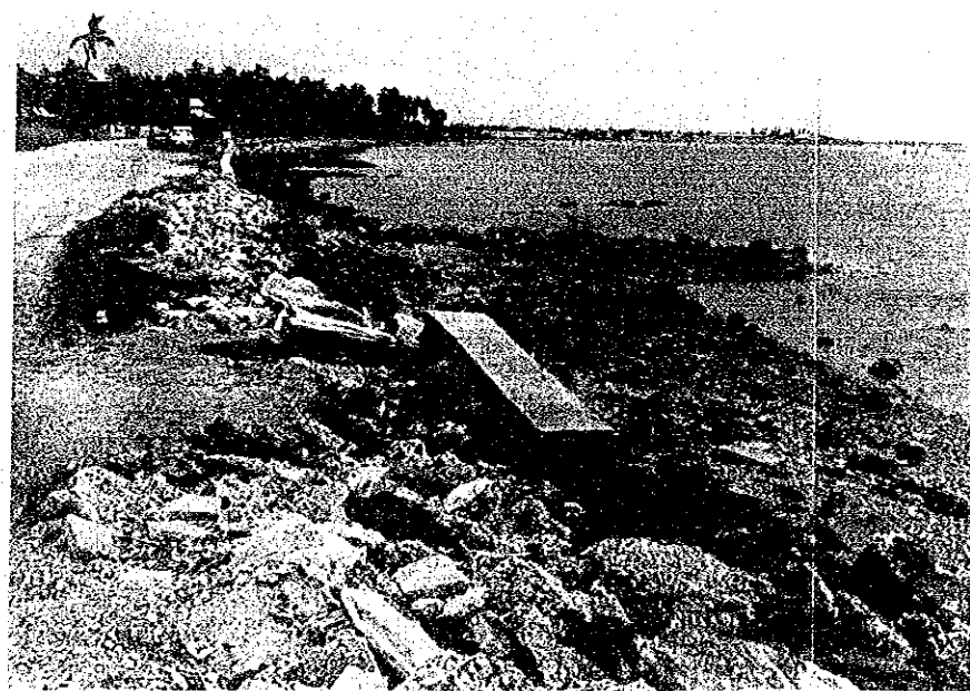
東側既設護岸（パラベット式）
