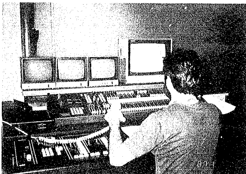
スタジオ副調整室照明操作卓
