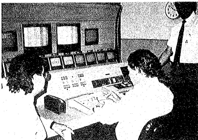
主調整室スイッチャー卓 (番組切り替えは手動で行っている)
