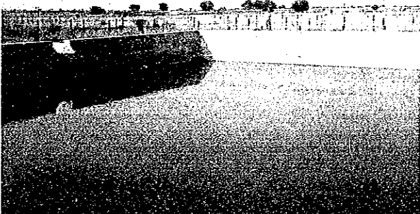
サブセンター（ネパールガンジー農業試験場）の貯水施設
