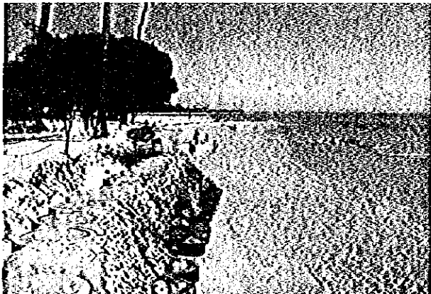
南東のモンスーンによる風浪で、前浜がなくなり、護岸が動いた。(ヌサ・ドゥア海岸)
