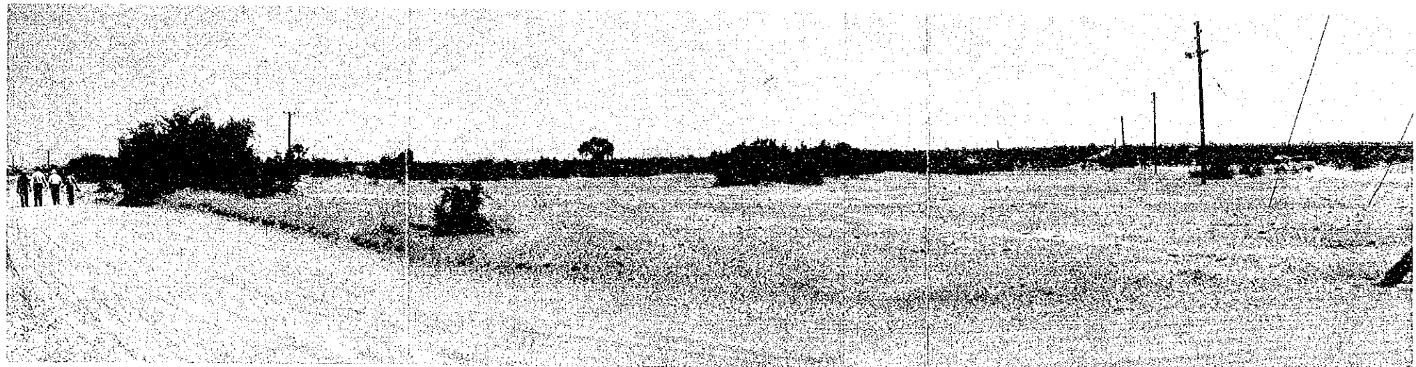
建設予定地を南東側より望む
