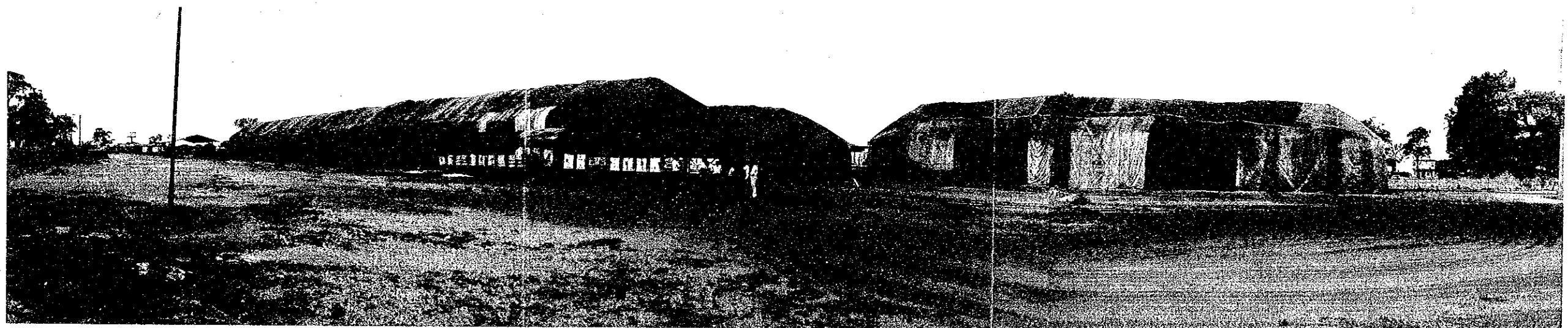
既設デポにおけるメイズの保管状況
