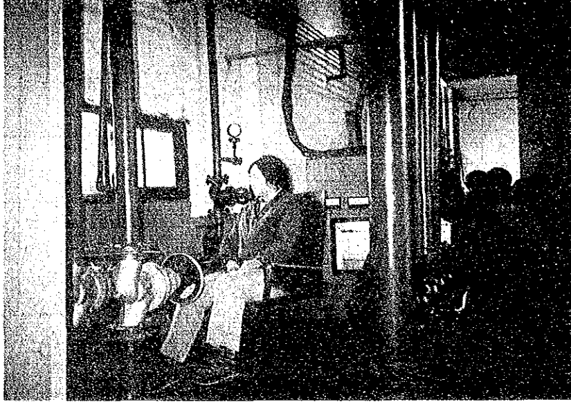
写真2.2.2-1 合成塔操作室
