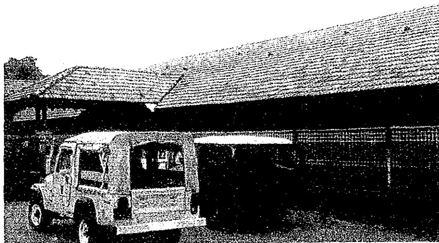
マンダレー総合病院小児病棟の外観
