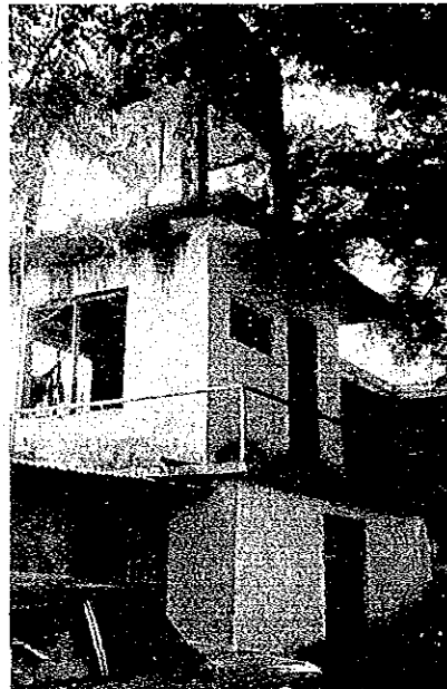
ビルディングD隣接の給水塔
