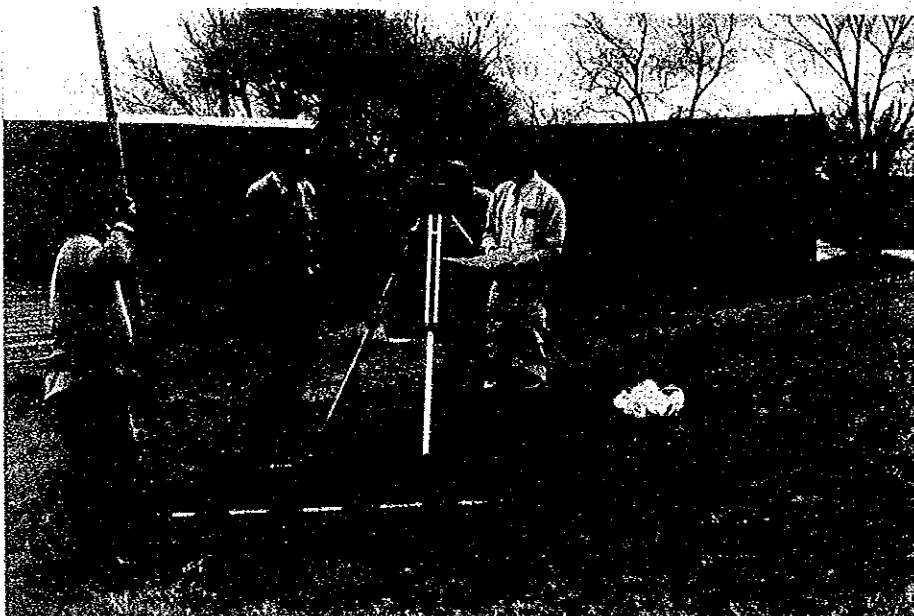
No.9 Levantamiento en el terreno reservado para la construcción de las instalaciones. Investigación de la resistencia del terreno.
