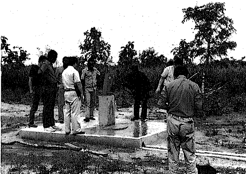
フェーズ I 供与ポンプ Ketou 郡 ODOKOTO 村にて
