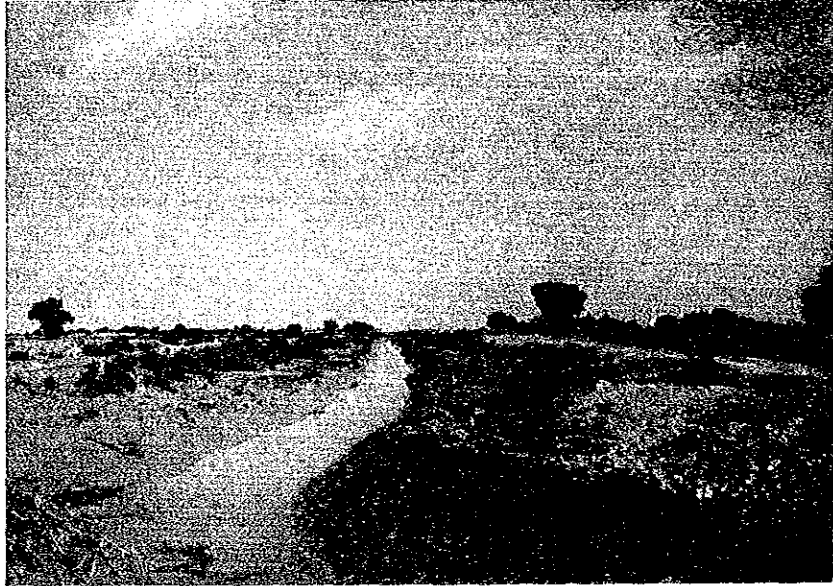
バットフィーダー水路からのBAR I支線
