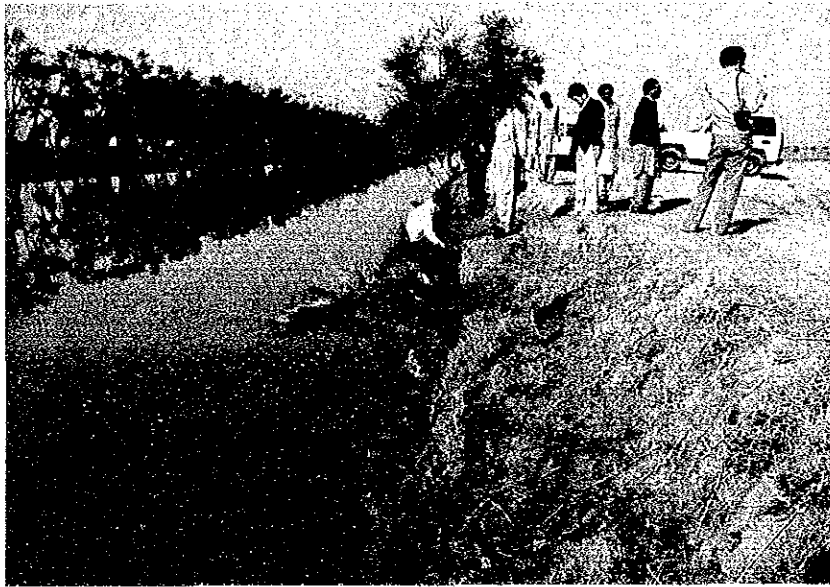
キルタール水路からの取水口
