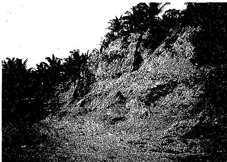
ボホール島の道路建設用資材調達現場
