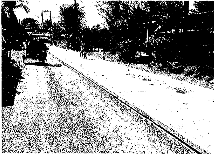
ブラカン州の州道舗装工事 (1)
