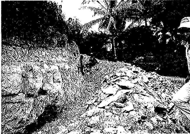
バランガイ道路の道路工事現地(拡幅) (2)
