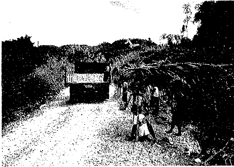
ボホール島のバランガイ道路工事 (1)
