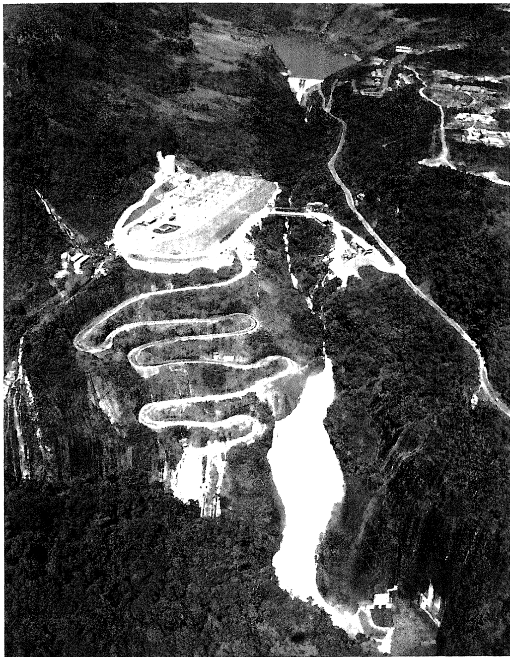
開発協力事業 インドネシアの北スマトラ州アサハンにおけるアルミニウム製錬事業（中央に見えるのが製錬工場）に関連するインフラ施設整備に対する協力
