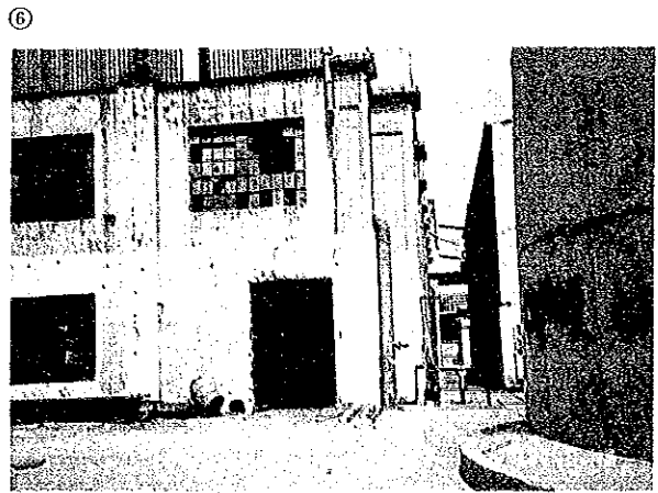
↑ “A” STATION 建屋 ↑ “BX” STATION 用復水タンク
