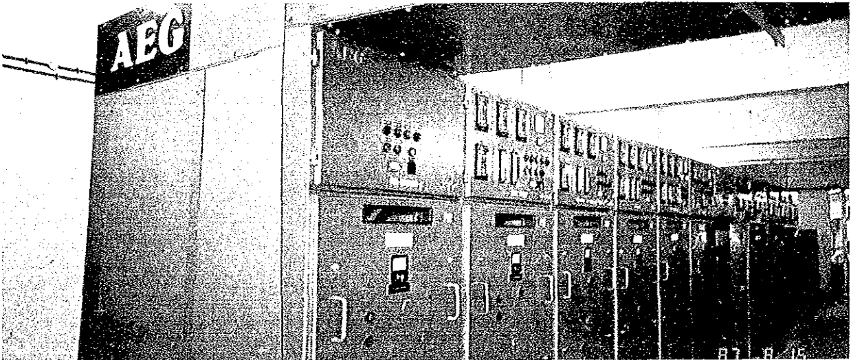
11KV SWITCHGER ROOM
