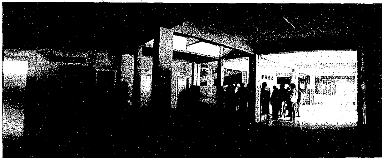
同上建物内部
