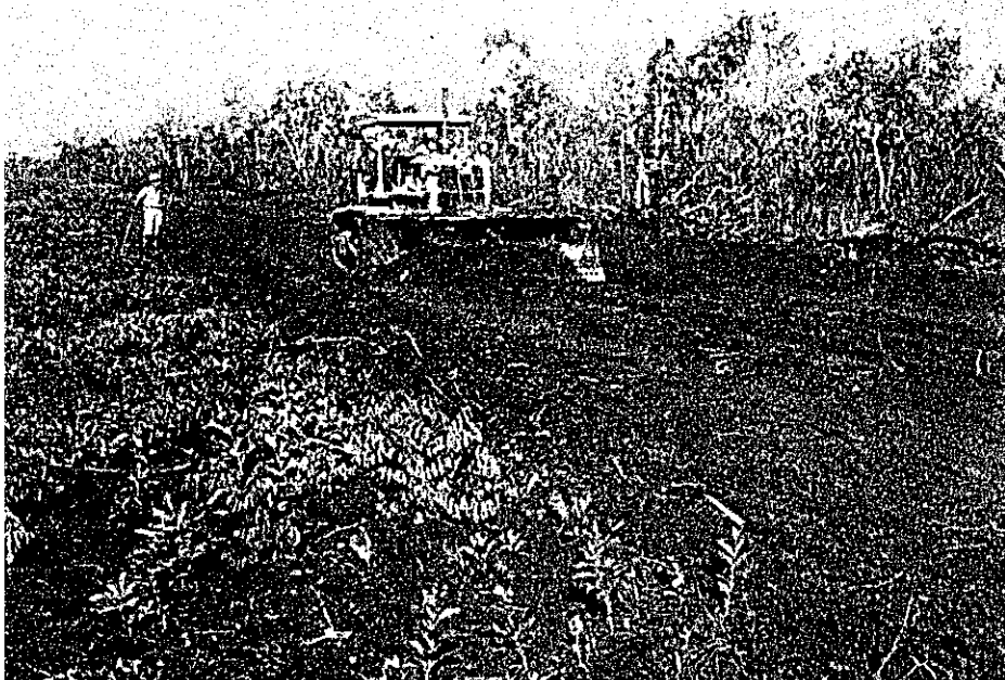
バルゼア・ アレグレ移住地 セレスチーノ駅周辺 の市街地の境界道路を ブルドーザーで造成し ているところ。
