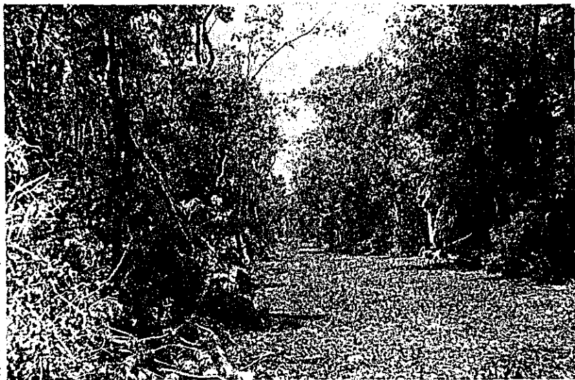
建設中の道路 市八メートルの道路が 2キロの甚整の日に切り開かれてい る。この両側の高さ三メートルに及 ぶ原始林を焼払って開拓する。
