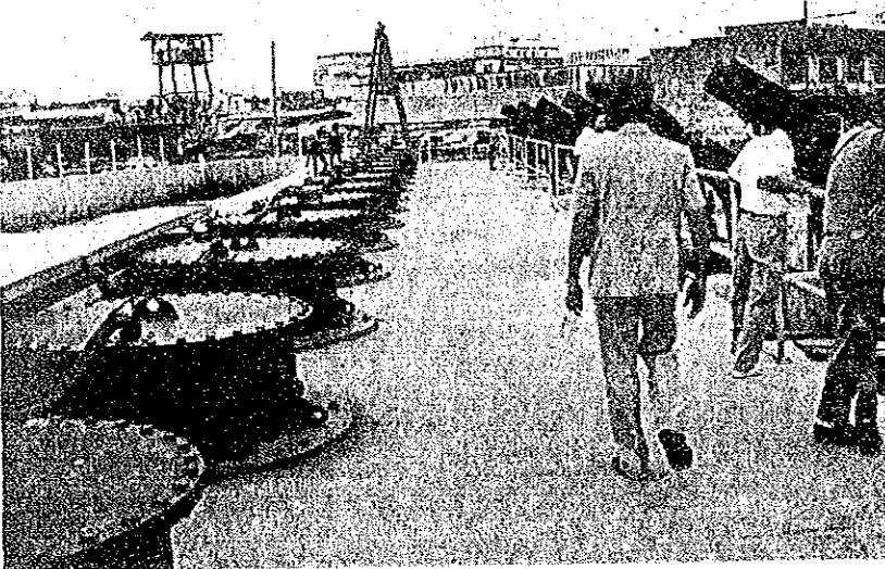
ポンプ及びスクリーンの据付け状況
