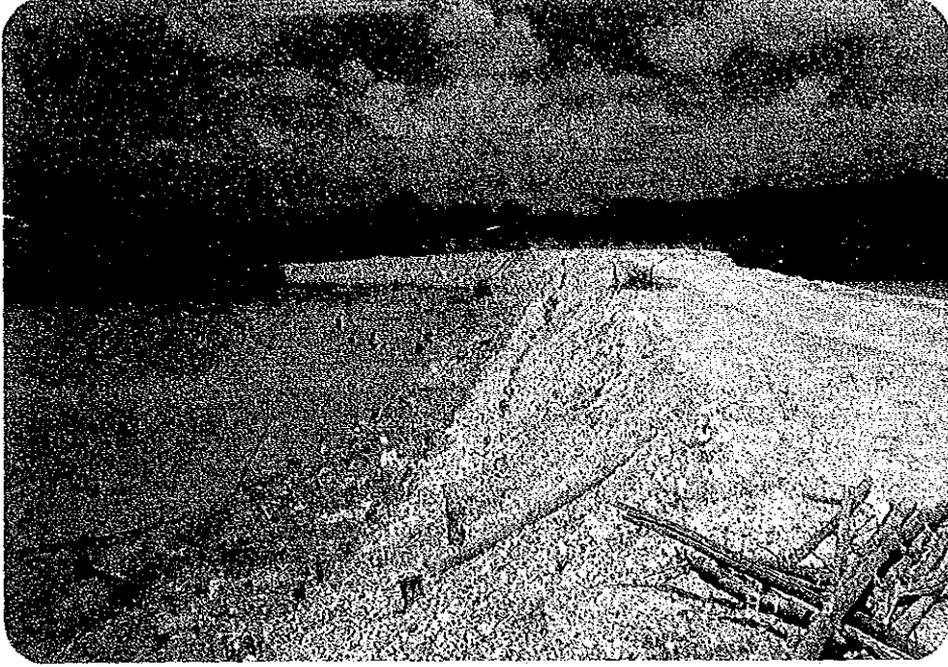
防潮堤：チャングブリ川河口から約1.8 km上流に位置し堤長90 m，堤頂幅5 m，土留めとしてφ200 mm  $l=6\sim 8$  mの木杭を使用している。例年乾期の始まりに建設し，雨期には撤去するため維持管理費が高んでいる。
