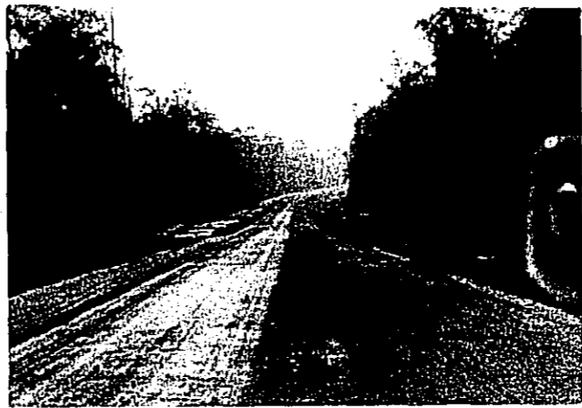
基礎ができた道路の全景
