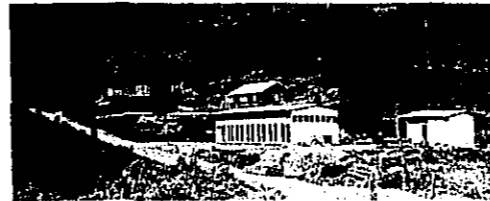
モデル事業林の機械庫、油庫、休憩所等の施設
