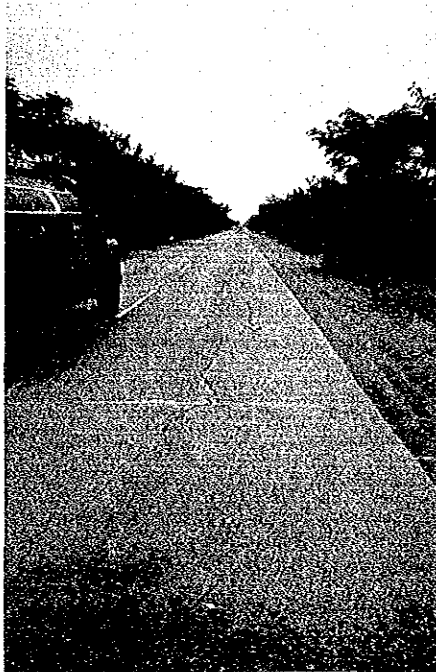
LONGITUDINAL CRACK
