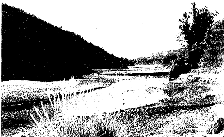
SITIO PLANTEADO PARA LA CONSTRUCCION DEL PUENTE
