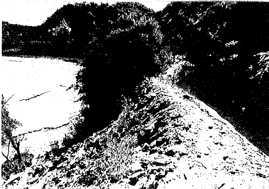
SITIO PLANTEADO PARA EL MEJORAMIENTO DEL CANAL DE IRRIGACION
