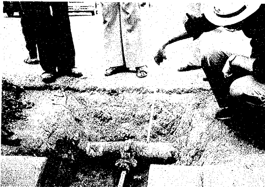
Conduite d'eau (point de captage), Kimpese
