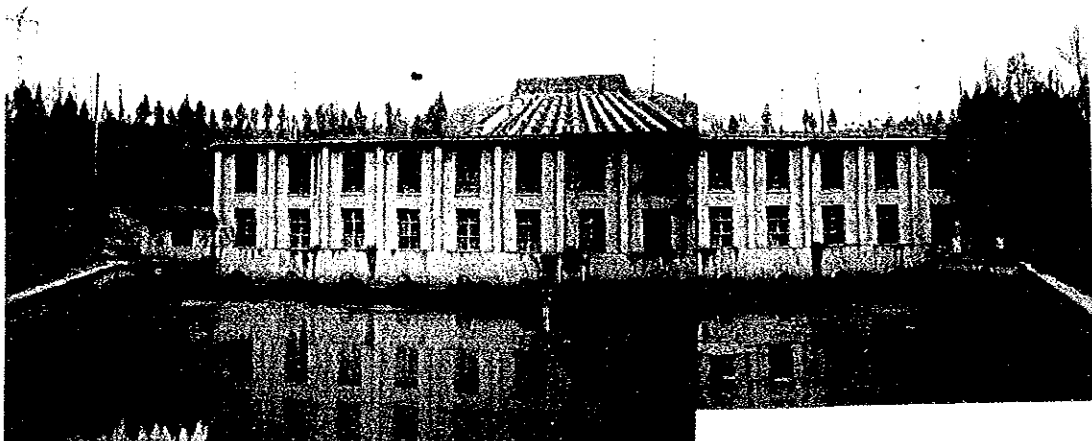
大岡坡2級ポンプ場
