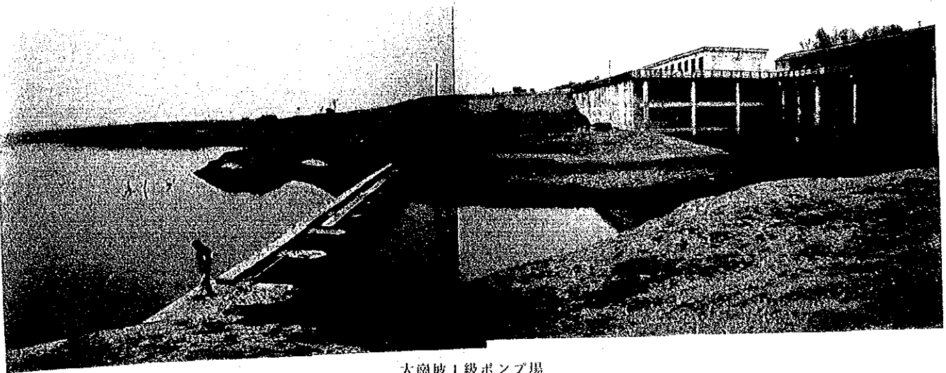
大岡坡1級ポンプ場 (左側の河川は唐河)
