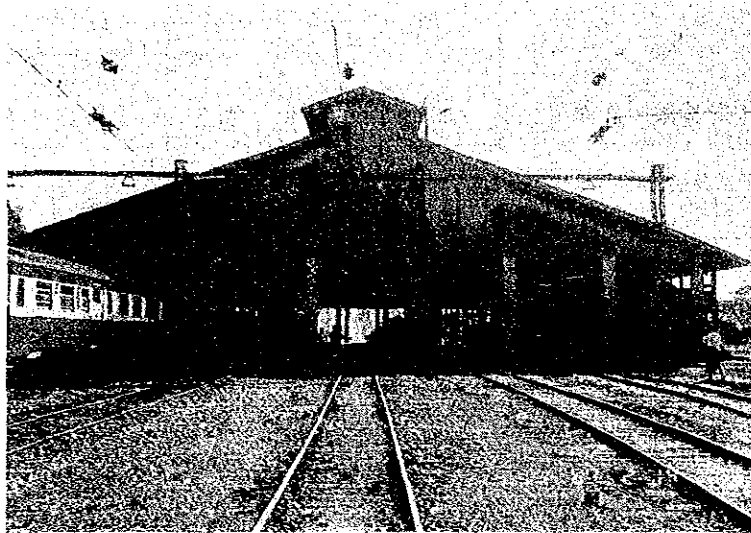
写真 5 - 17 BUKIT-DURI車両基地の検修場
