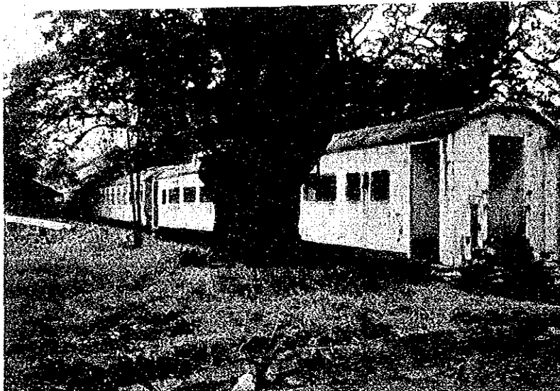
写真5-2 マンガライ工場内の留置線
