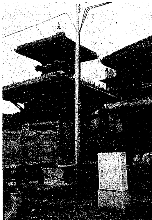
Patan, フランス製鋼管柱
