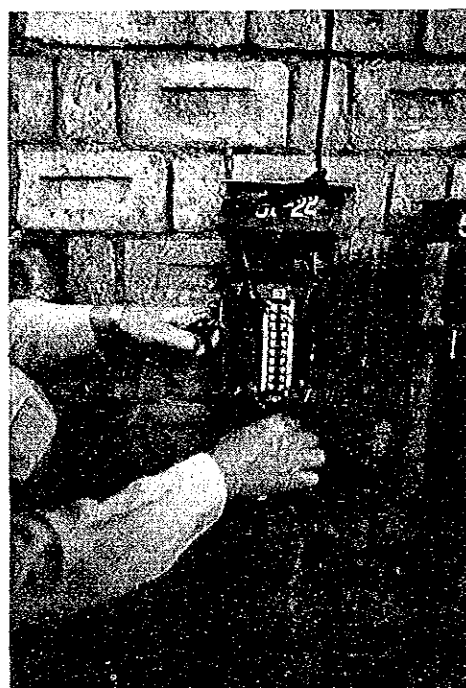
Islamabad 地下配立上り配電盤
