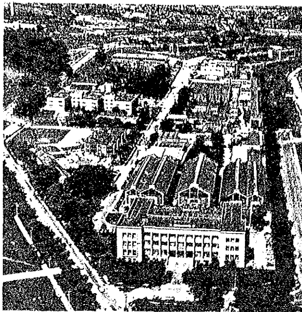
写真1 サンパウロ州技術研究所全景
