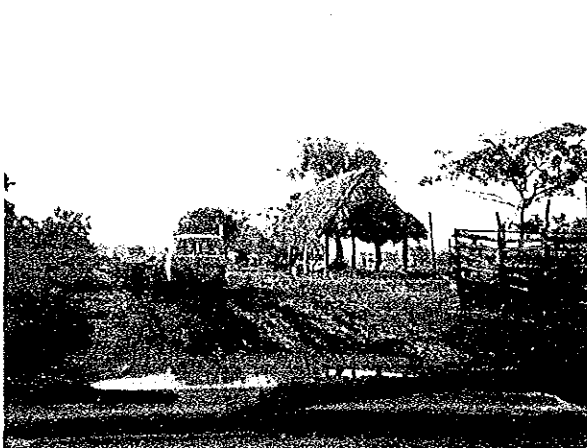
現道（トリニダから7 km付近）
