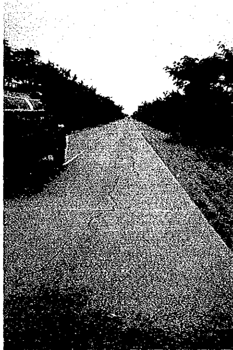
LONGITUDINAL CRACK
