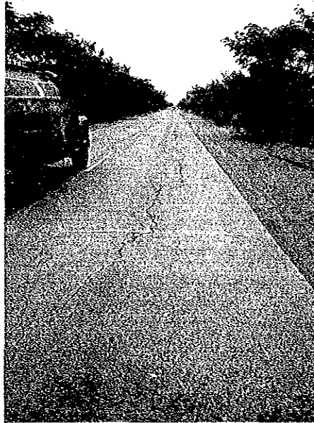
LONGITUDINAL CRACK
