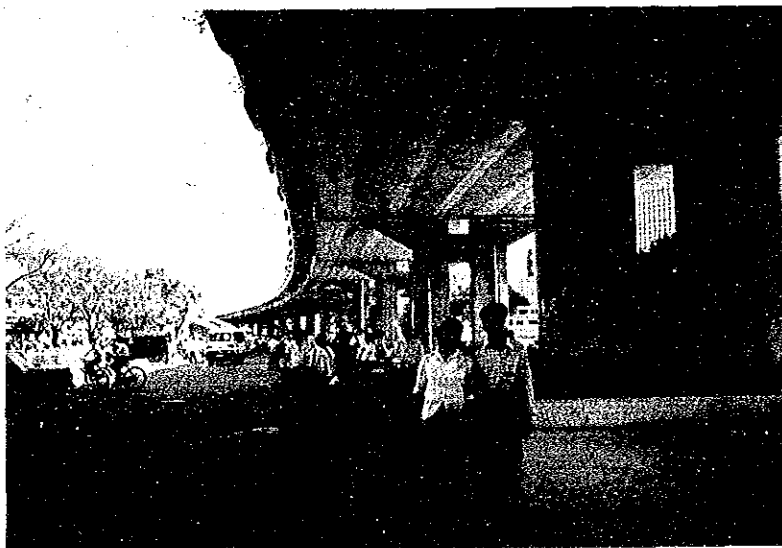
(14) 広州市内高架式高速道路
