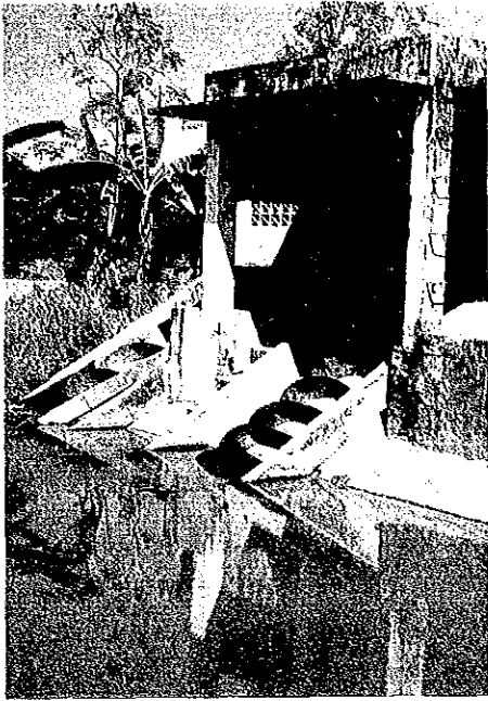
スクリータイプの水揚機 (BINALONAN)
