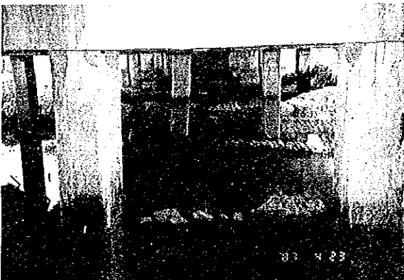
(写真-11) LABNOAN パイルベント脚。 旧橋脚の残骸が残っている。
