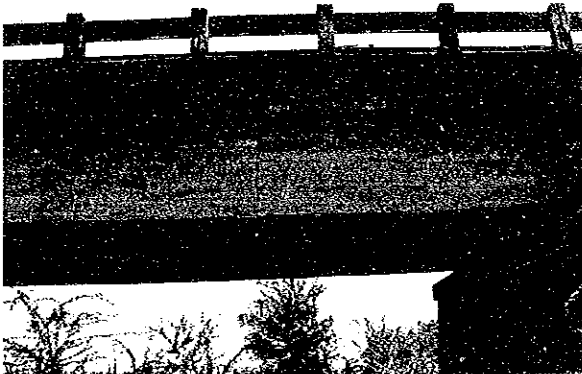
(写真-15) GEN LUNA ウェブにコールドジョイントが見える。
