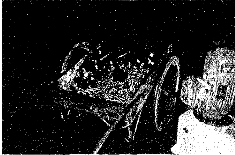
図IV-1-43 ボルト類の搬入
