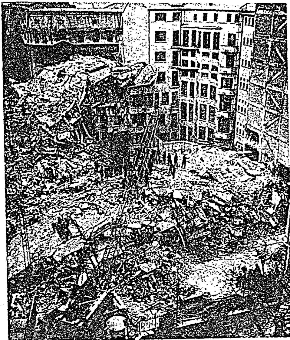
写真 5.24 崩壊した補強煉瓦造建物
