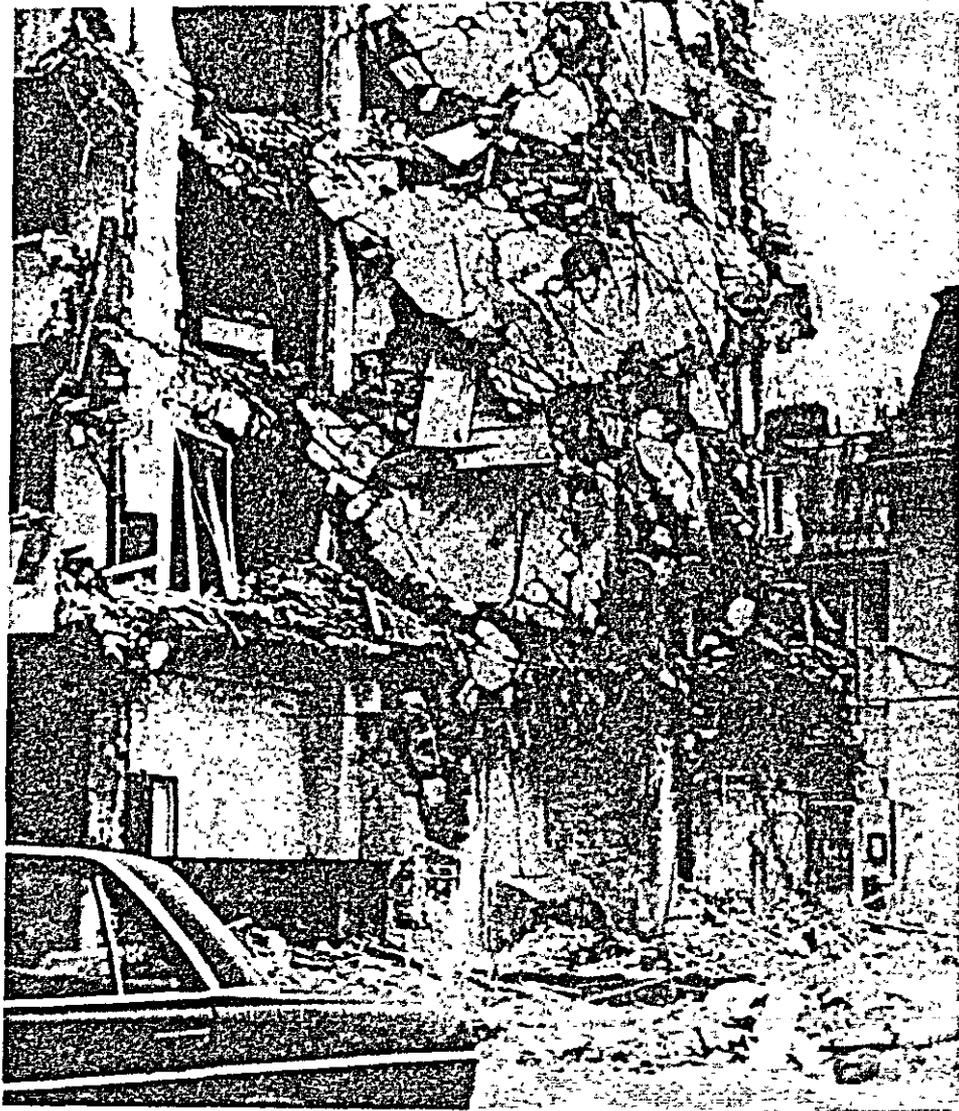
写真 5.2 5 崩壊した補強煉瓦造建物
