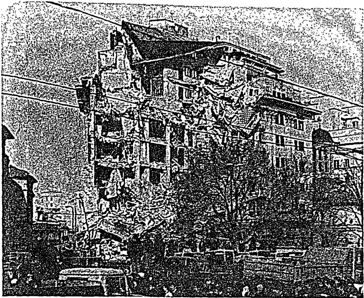
写真 5.20 崩壊した補強煉瓦造建物
