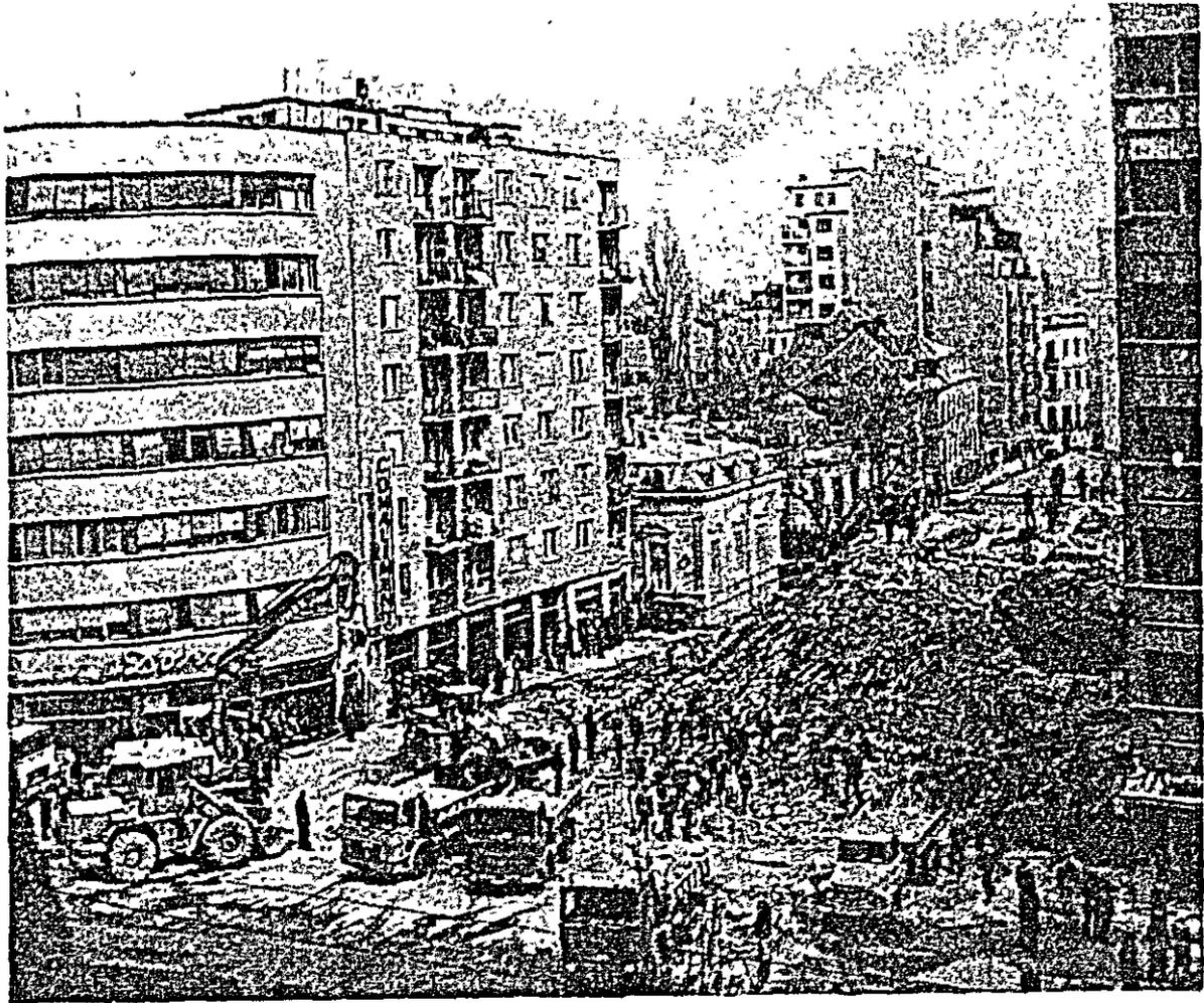
写真5.27 崩壊した補強煉瓦造建物
