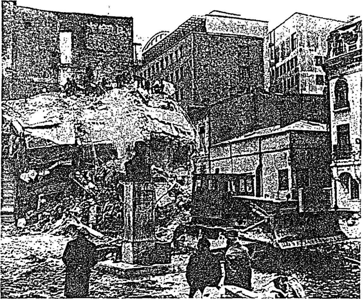
写真 5.23 崩壊した補強煉瓦造建物
